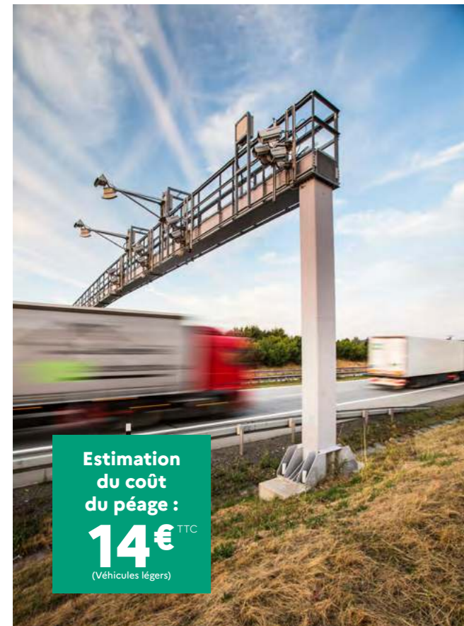
Exemple de portique de péage en flux libre
