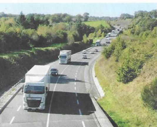
La déviation de Bellac, mise en service en 2008.
